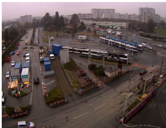
Le secteur de Bachet avant les travaux de l'interface
